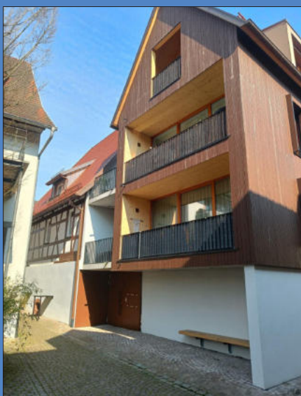
Bâtiment neuf à Haslach en harmonie avec l'habitat traditionnel
