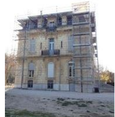
Echafaudage de pied périphérique et en bas de pente
