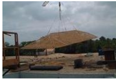
Montage de charpente au sol
