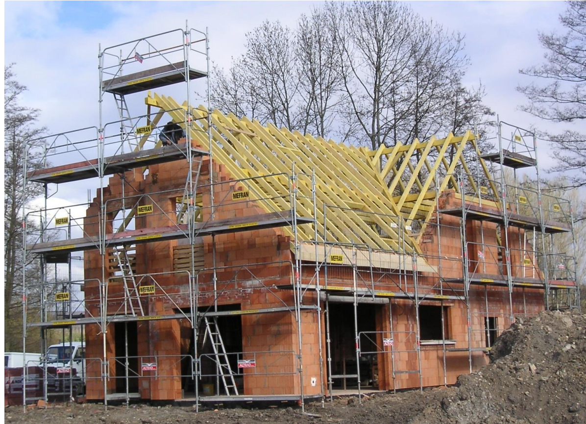
Echafaudage de pied
