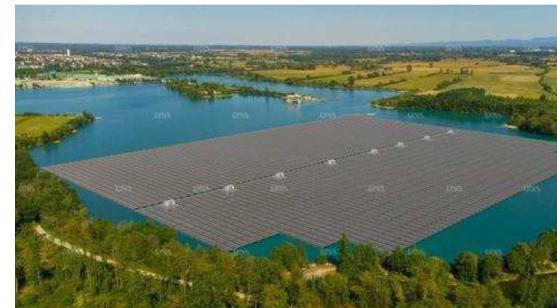
Parc solaire flottant
